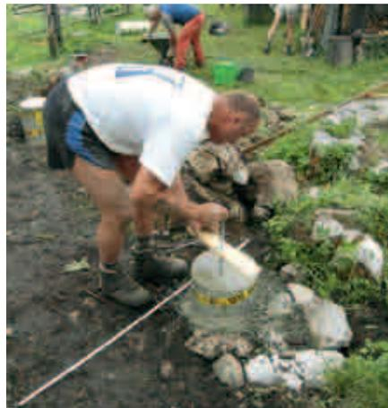
Betonieren und Einrichten der Punktfundamente
