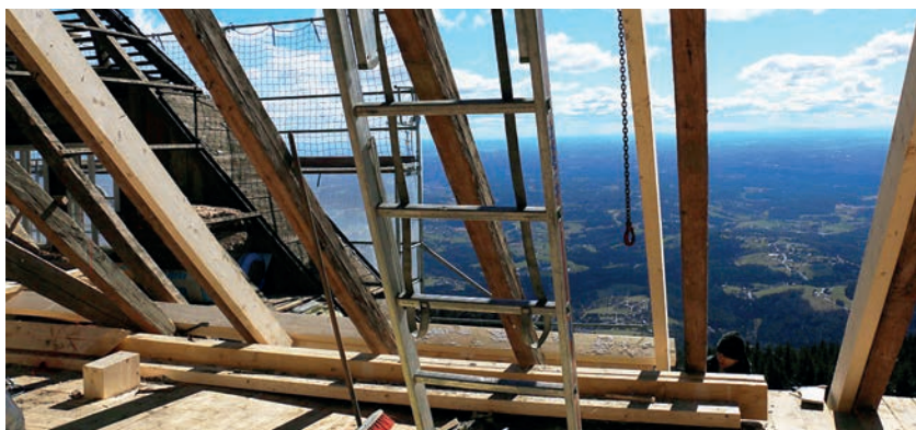
Ausblick vom geöffneten Dach
